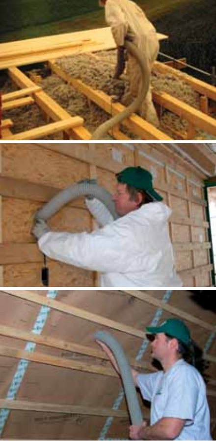
Isolamento di copertura con getto di fiocchi di cellulosa in estradosso, Casa Willeit a Gais, arch. A. Willeit. (Foto Fotostudio Eheim, Bressanone)
